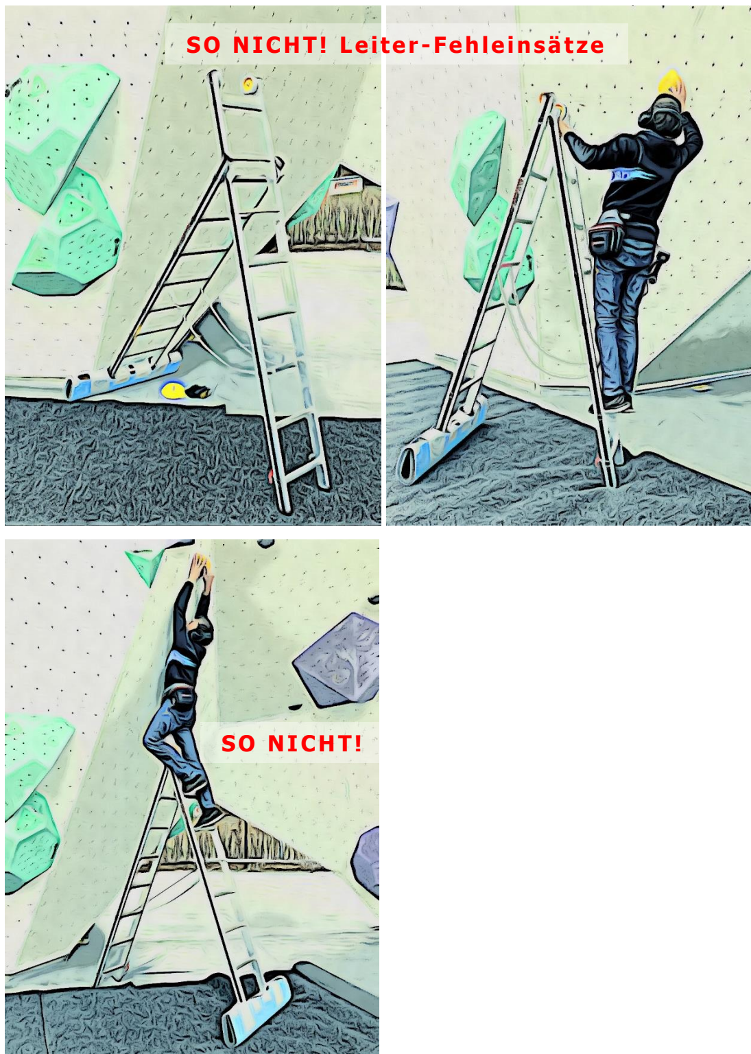
Abb. 13: Fehleinsätze Mehrzweckleiter: Generell kein Einhängetritt bei den Sprossen verwendet, außerdem: Arretierungsfehler; Leiter nicht voll ausgeklappt; zu hoch aufgestiegen und überstrecktes Arbeiten
