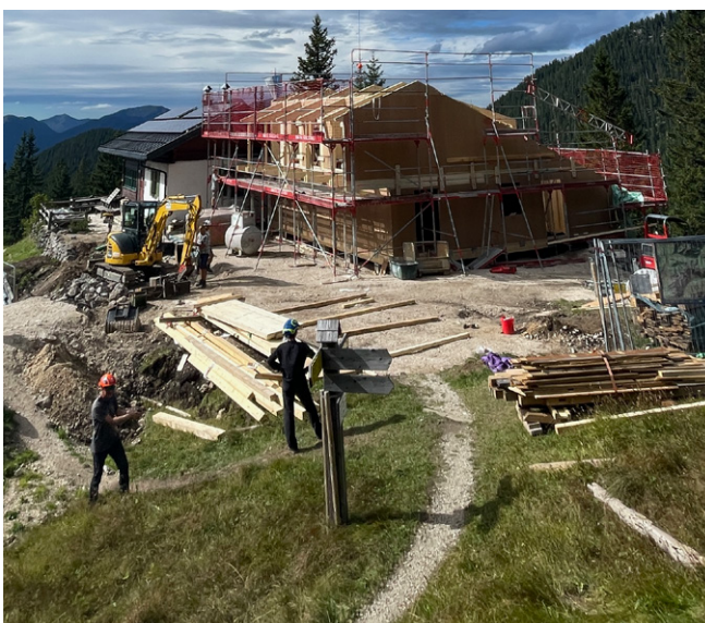
Baustelle der Hochlandhütte der Sektion Hochland des Deutschen Alpenvereins e. V.
