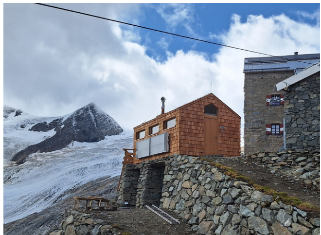
Neues Nebengebäude der Neue Prager Hütte zur Beherbergung der Trockentoiletten
