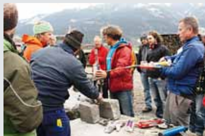
Am Kapruner Bauhof testen die Wegewarte schweres Gerät für den Seilsicherungen-Bau.
