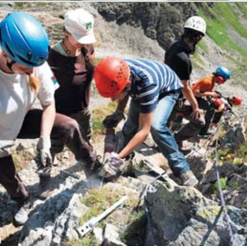
Brocken schleppen und zentimetergenau einpassen: feinfühliges Schwerarbeit. Steile Felspassagen werden auch mal mit Drahtseilen abgesichert.
