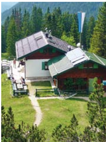
Dr. Irmtraud Dreßl-Kasy Hochlandhütte (1623 m), 39 Lager, 12 Notlager, 82481 Mittenwald, Schöttlkarstr. 10, Tel. Hütte: 0174/989 78 63
