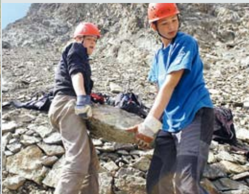
Brocken schleppen und zentimetergenau einpassen: feinfühliges Schwerarbeit. Steile Felspassagen werden auch mal mit Drahtseilen abgesichert.
