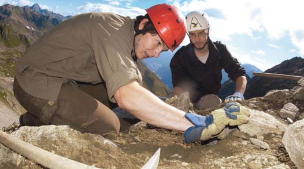
Brocken schleppen und zentimetergenau einpassen: feinfühliges Schwerarbeit. Steile Felspassagen werden auch mal mit Drahtseilen abgesichert.
