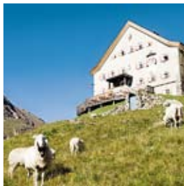
Das Hochjoch-Hospiz in den Ötztaler Alpen ist von Vent aus nur zu Fuß erreichbar und hat keine Materialseilbahn.
