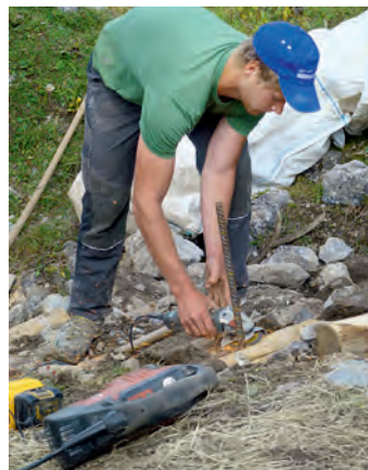
Wegesanierung im Hochgebirge ist immer aufwendige Schwerarbeit. Finanzielle Unterstützung durch seinen langjährigen Partner hilft dem DAV.
