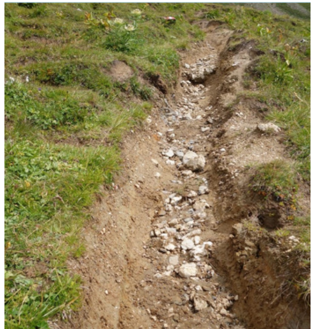
Abbildung 6: Erosionsrinne. (Bild: Derungs)
