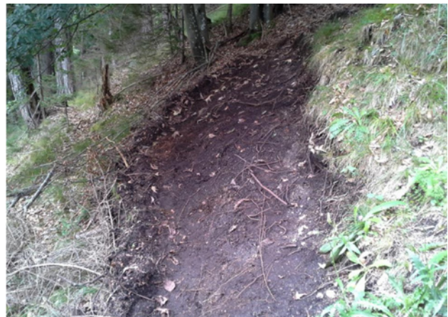
Abbildung 7: Wegkantenabbruch. (Bild: Amor)
