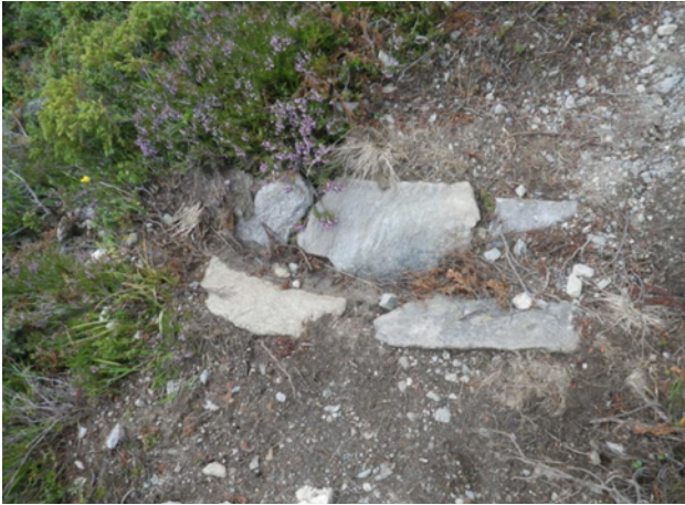
Abbildung 13: Querrinne aus Steinplatten. (Bild: Amor)
