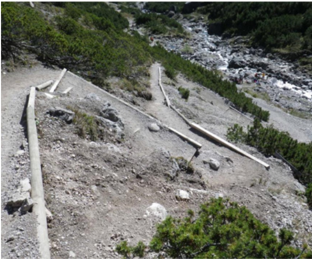
Abbildung 24: Wegkantenstabilisierung. (Bild: Amor)
