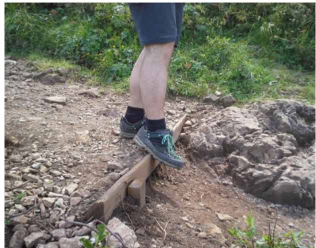
Abbildung 19: Kantige Stufe für Wanderer gut, bei MTB Benutzung wirkt eine große Kraft! (Bild: Amor)
