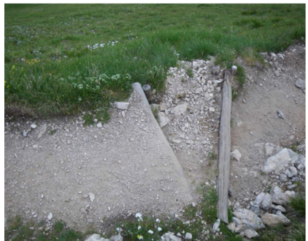
Abbildung 12: Querrinne aus Baumstämmen. (Bild: Amor)
