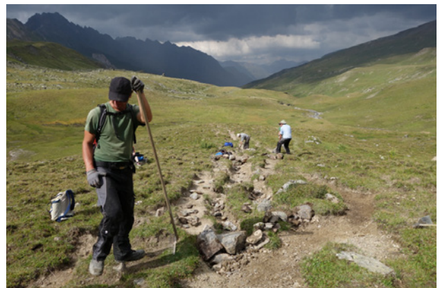
Abbildung 17: Wegführung und Sperren von Abschneidern mit Steinen (Bild: Derungs)
