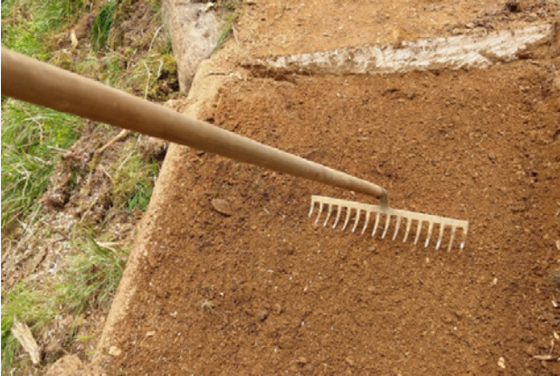
Abbildung 33: Rechen eignen sich hervorragend zum Aussortieren von kleinen Steinen und losen Wurzeln. Ideal auch zum Ebnen der Oberfläche. (Foto: C. Piccolruaz)
