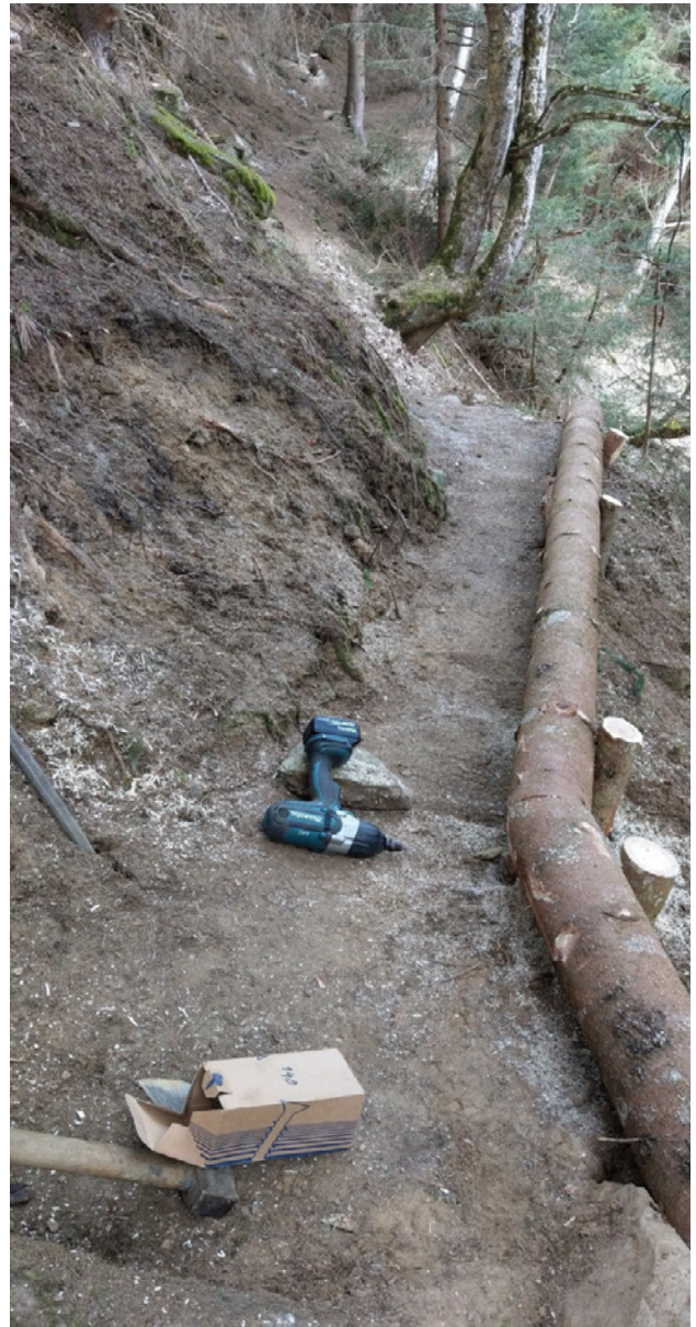
Abbildung 23: Vorbereitete Wegkante aus massiven Baumstämmen d=20\text{cm} , vor der Verfüllung. (Foto: C. Piccolruaz)
