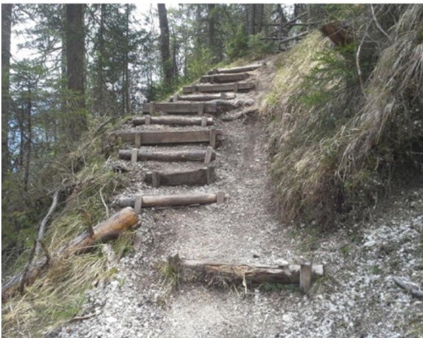
Abbildung 18: Treppe mit nebenliegendem Fahrbereich. (Bild: Amor)
