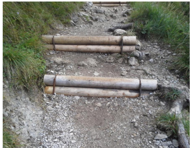
Abbildung 20: Runde Stufe für Wanderer weniger gut, aber dafür bei MTB Benutzung haltbarer!. (Bild: Amor)
