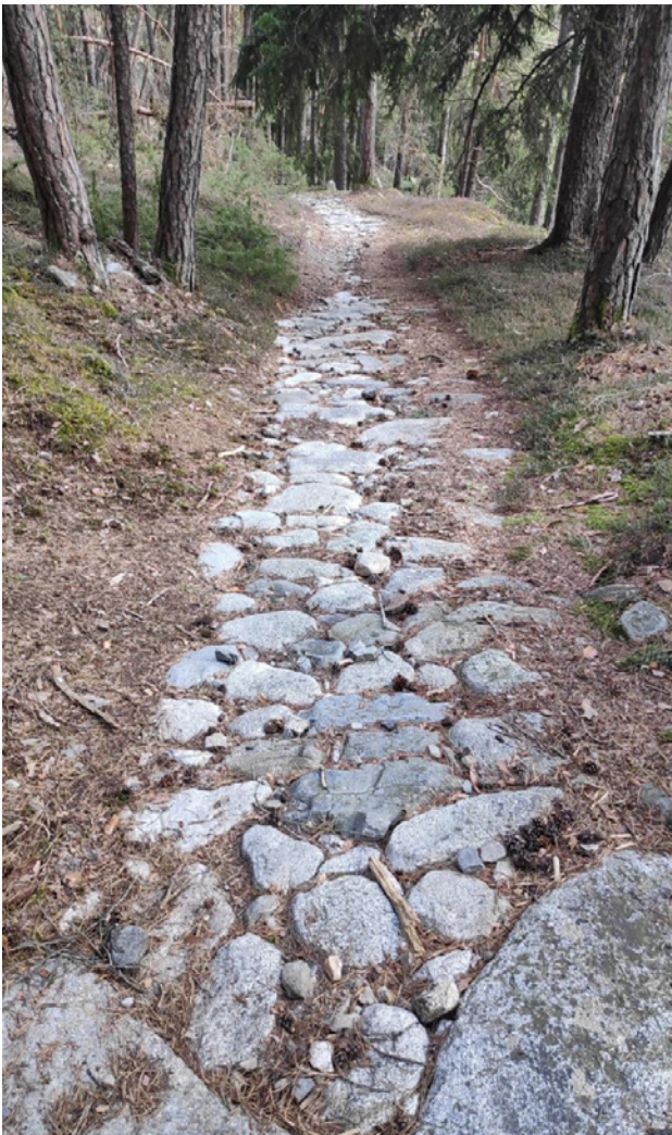
Abbildung 25: Steinarmierung. (Foto: B. Trotter)
