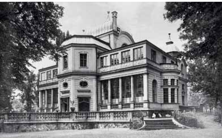
Aus Alt mach Neu: Die schnuckelige Kuppel fiel dem Ersten Weltkrieg zum Opfer. Heute strahlt die Fassade frisch saniert.
