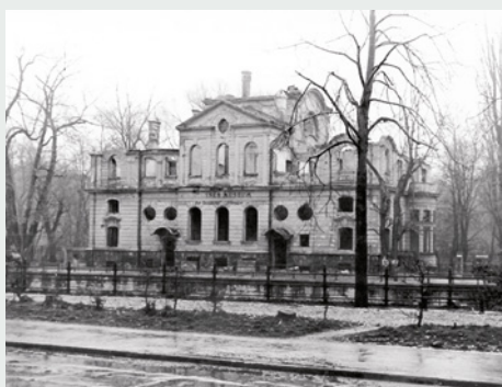
Nur noch ein Gebäudeskelett: Ruine des Alpinen Museums 1945
